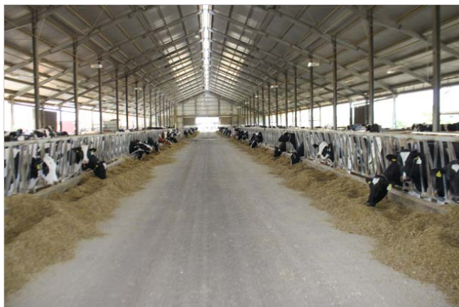
Abbildung 9: Standard für viele Neubauten ist der Verzicht auf geschlossene Außenwände.
