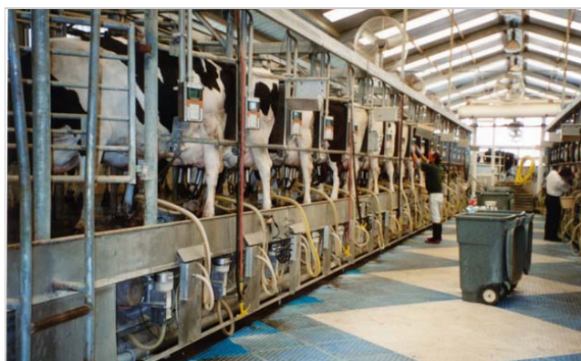
Abbildung 10: Auch im Melkstand ist für eine optimale Luftströmung zu sorgen; hier: Fischgrätenmelkstand in einer großen Milchkuhfarm in Kalifornien.
