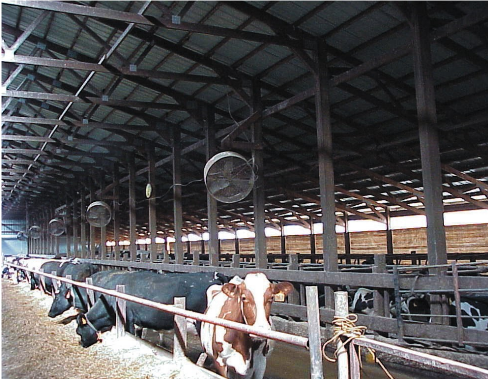
Abbildung 4: Anordnung der Umluftverfahren in paralleler Strömungsrichtung
