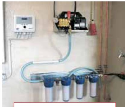
Pumpe, Filter und Befeuchtungscomputer sind die Komponenten einer Hochdruckvernebelungsanlage.
