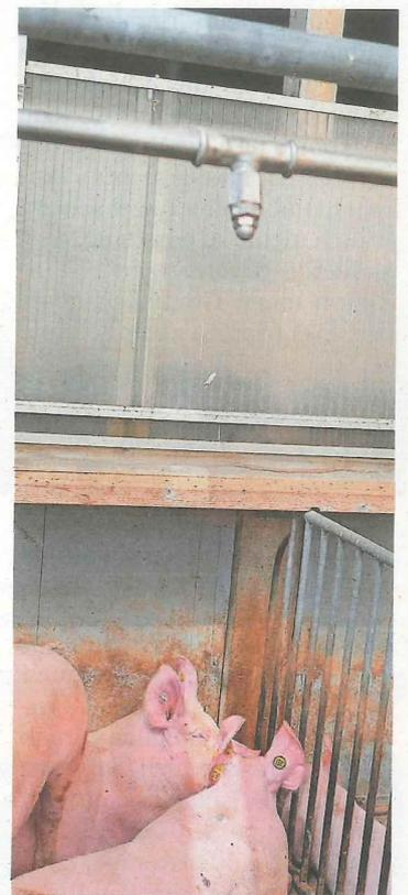
Niederdruckbefeuchtung eines Auslaufs
