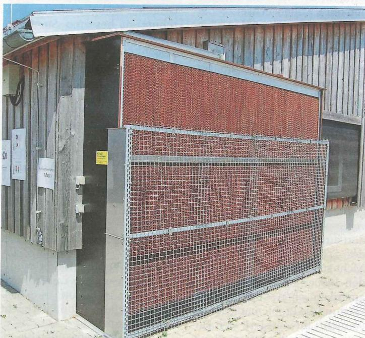
Kühlpad an einem Maststall
