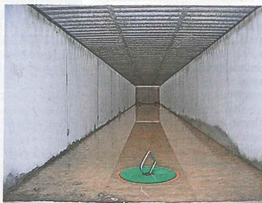
Links: Düse einer Sprühkühlung im Unterflurzuluftekanal. - Rechts: Gefluteter Unterflurzuluftekanal.
