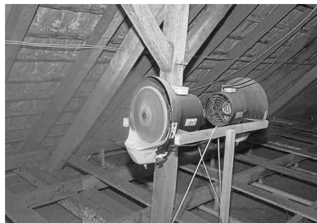
Der Wasserzerstäuber „Friggy“ nutzt das Prinzip der Verdunstungskühlung.
