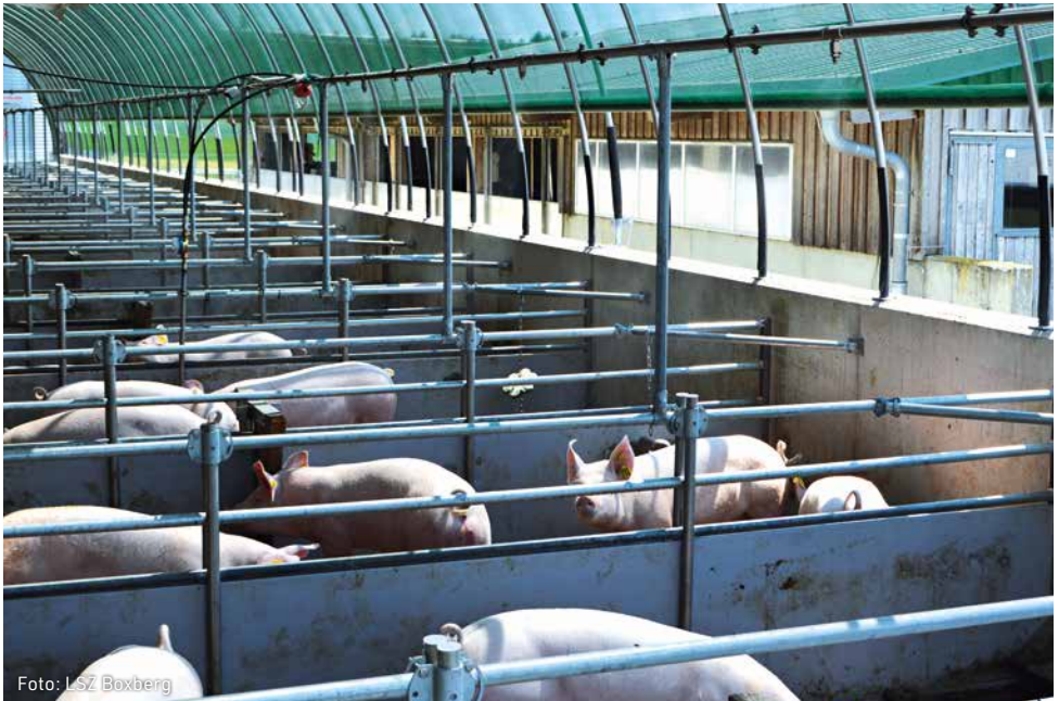
Auslauf mit Sonnenschutznetz und Niederdruckbefeuchtung, um die Schweine zu kühlen.
